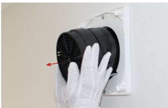
Herausziehen von inVENTron®: Leitwerke und Reversierventilator
