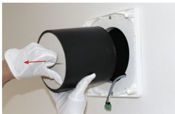
Herausziehen des Keramikwärmespeichers
